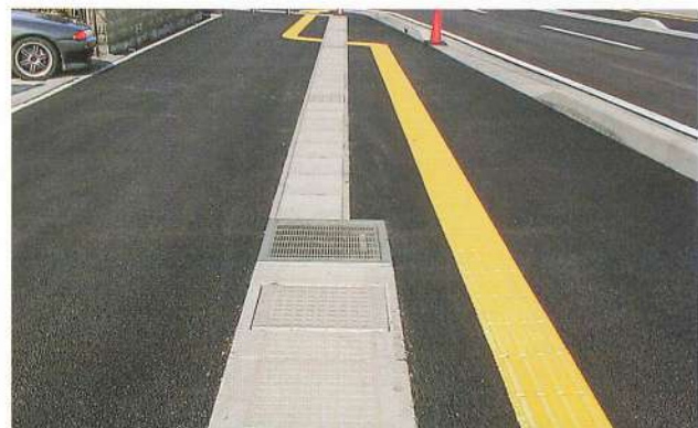
▲ 可変側溝と外幅ピッタリ
