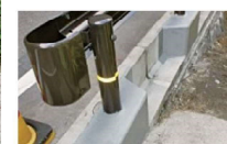
補修した2本の近景
