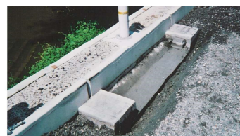
③底版上の土を取り除いた状況
