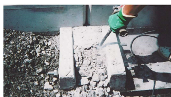
④間詰めコンクリート除去
