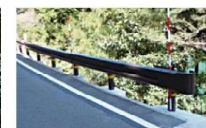
補修後の全景
