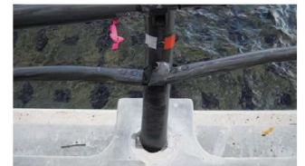
横断方から見た状況
