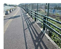
補修した後の全景
