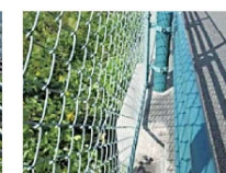
補修した近景
