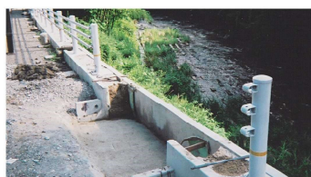
⑤製品を撤去した状況
