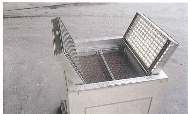
▲ 大型柵は2枚割れグレーチング
