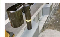
補修した2本の近景
