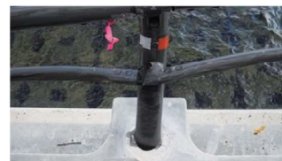
横断方から見た状況
