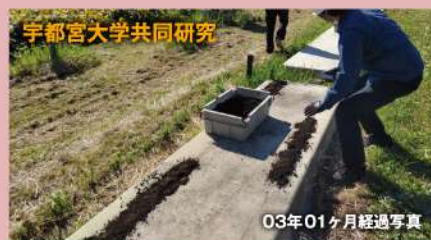
目地に土溜まりを作る作業 撮影日：2022年10月00日
