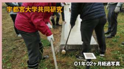
振動で目地を開かせる作業 撮影日：2020年11月00日
