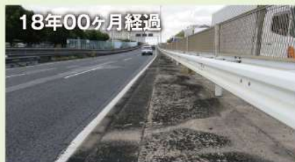
完了日：2005年12月 名古屋国道事務所 平成17年23号南橋歩道整備工事
