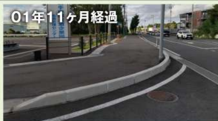
完了日：2021年10月 岩手県北上市 飯豊和田道路改良工事
