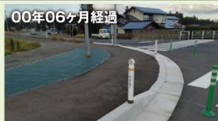
完了日：2022年4月 岩手県南広域振興局 一般道永沢地区歩道設置
