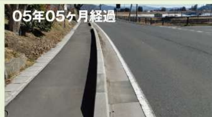
完了日：2018年9月 岩手県平泉町 町道祇園線道路改良工事
