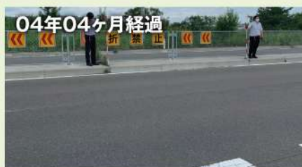
完了日：2018年3月 青森県三八地域県民局 八戸環状線道路改良工事
