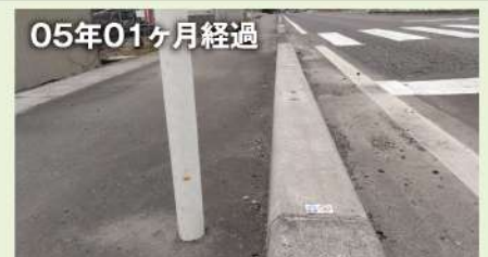
完了日：2019年2月 須賀川土木事務所 道路橋りょう工事中野須賀川線
