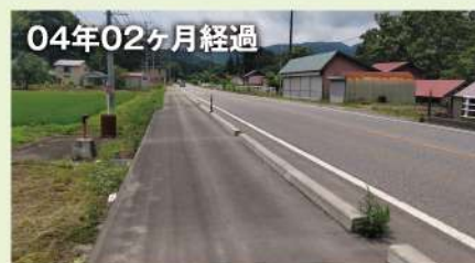
完了日：2019年5月 若松建設事務所 道路橋りょう整備工事国道252号線
