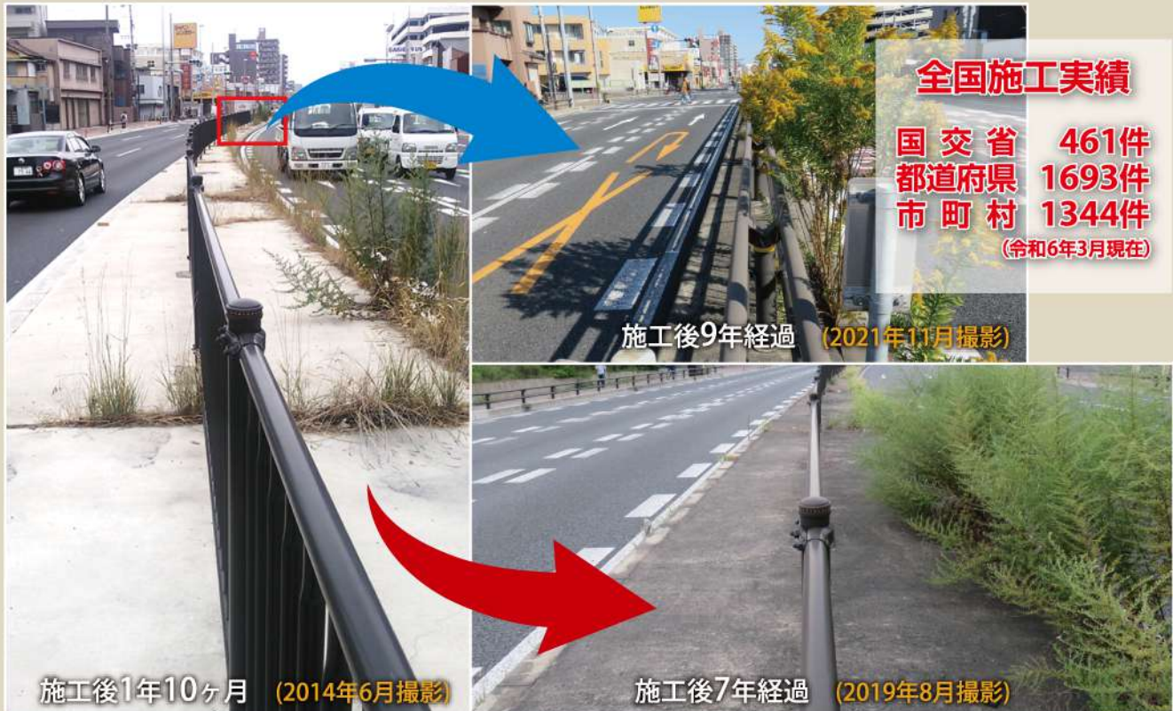
製品名：歩車境界ブロック、名古屋国道事務所 平成22年度22号枇杷島電線共同溝名西西工事【完了:2012.08】
