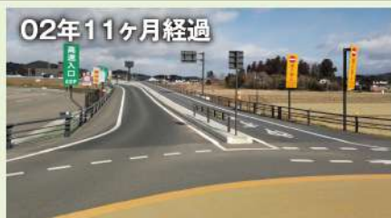
完了日：2021年3月 NEXCO東日本 北上管内舗装補修工事
