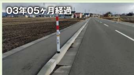
完了日：2019年10月 岩手県金ヶ崎町 第23号町道野田前野線道路改良工事
