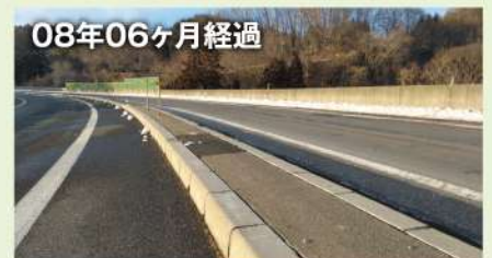
完了日：2015年8月 NEXCOメンテナンス東北 八戸管内道路保全工事一戸インター縁石取替工事
