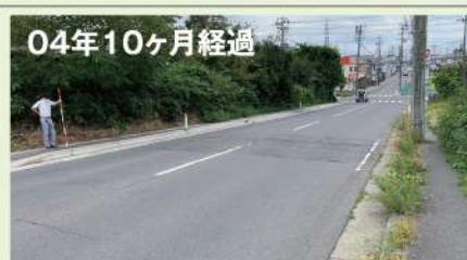
完了日：2017年11月 青森県八戸市役所 下大久保左部長根線歩道補修工事
