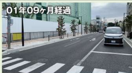
完了日：2021年12月 青森県八戸市役所 局屋部町線ほか道路付属施設設置工事
