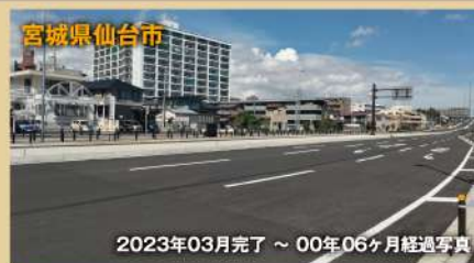
2023年03月完了～00年06月経過写真 宮沢根白石線（舟丁工区）西交差点 撮影日：2000年00月00日
