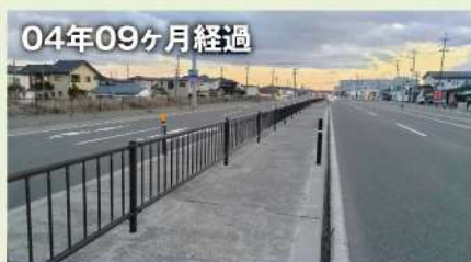
完了日：2019年6月 郡山国道事務所 鏡石前山地区改良舗装工事（国道4号線）
