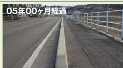
完了日：2019年2月 二本松土木事務所 防草工事(県道114号線)
