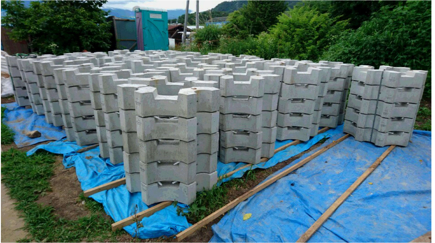
工事名：満開川溪流保全工事
