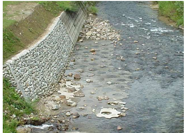
工事名:最上小国川(左岸) 河川災害復旧工事(4トン32個)
