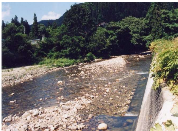
工事名:月布川右岸災害復旧工事
