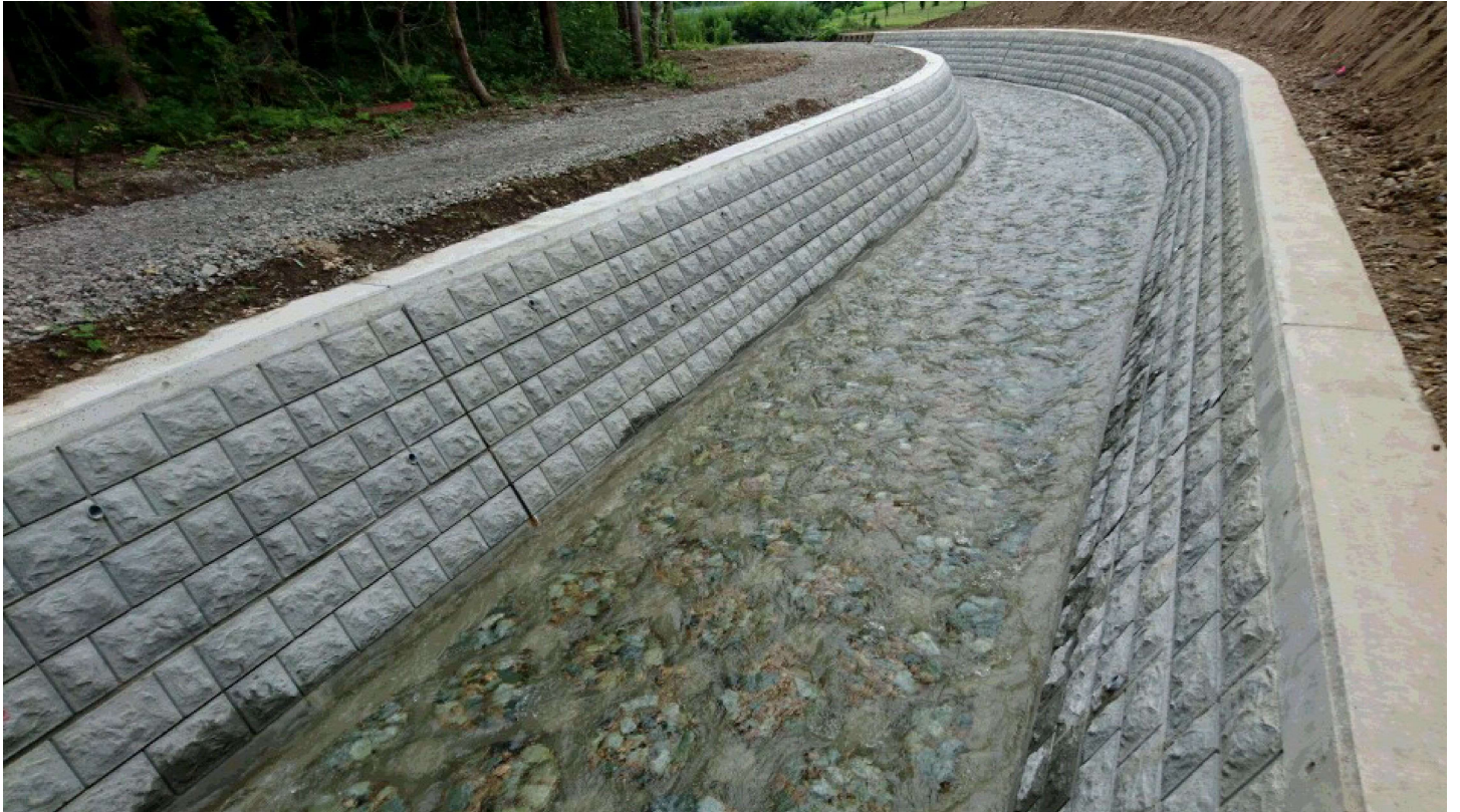
工事名：満開川溪流保全工事
