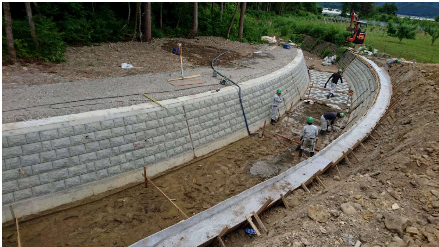
工事名：満開川溪流保全工事
