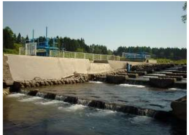
工事名:隼気川小規模河川改修工事(スーパーテクノ2トン21個)
