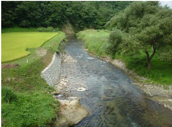
工事名:最上小国川(左岸) 河川災害復旧工事(4トン32個)
