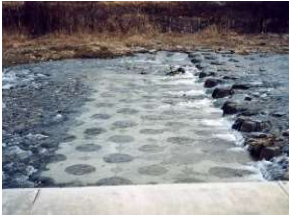
工事名:須川筋河川災害復旧工事(3トン27個)
