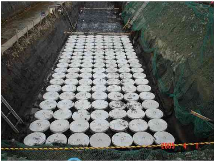
主要地方道天童寒河江線道路改良工事
