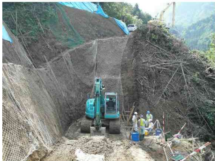
綱木川ダム(鳥川)補償林道工事
