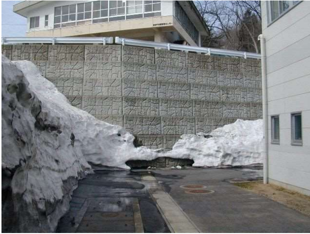
飯豊町立中津川小中学校建設工事
