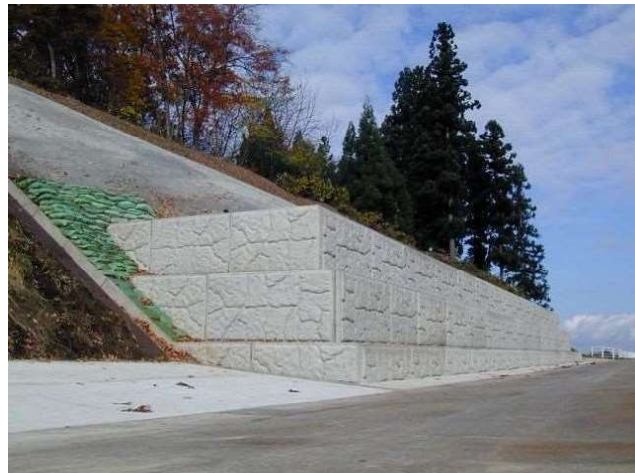
村山地区維持工事(国道 13 号)
