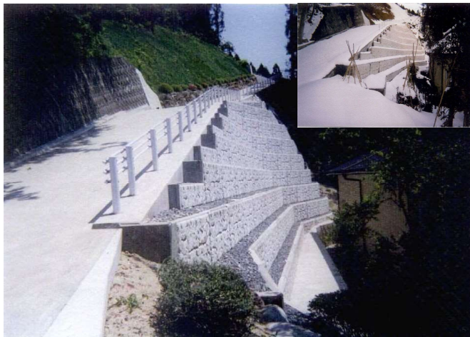
妙玄寺土止め擁壁工事
