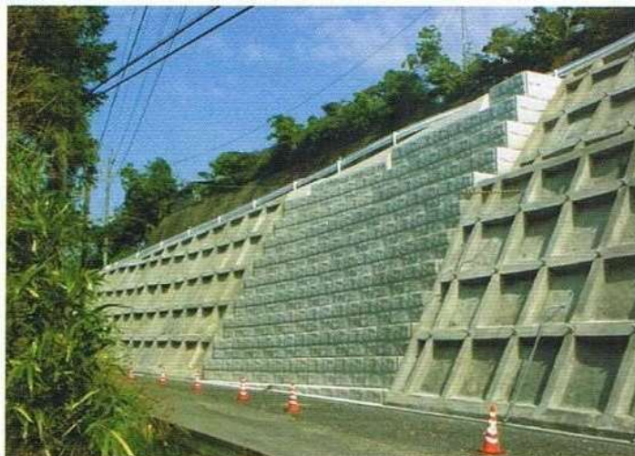
上下に道路で更に上部に住宅
