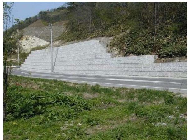
平成 11 年度長井大江線道路改良工事
