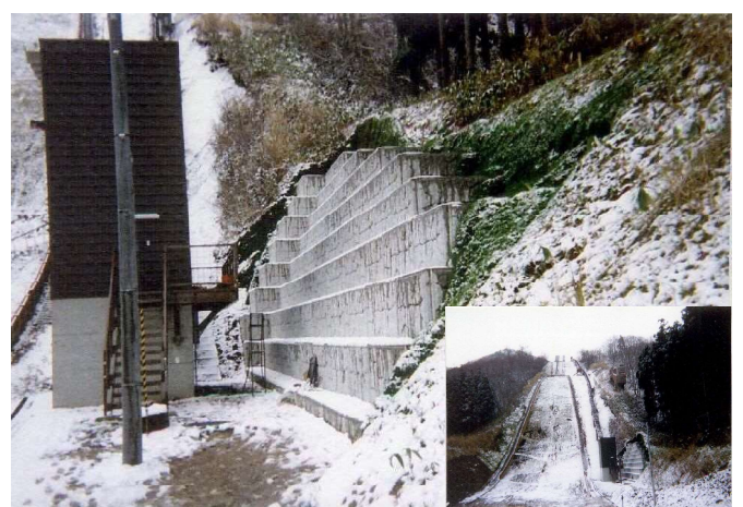
蔵王ジャンプ台選手搬送施設擁壁工事
