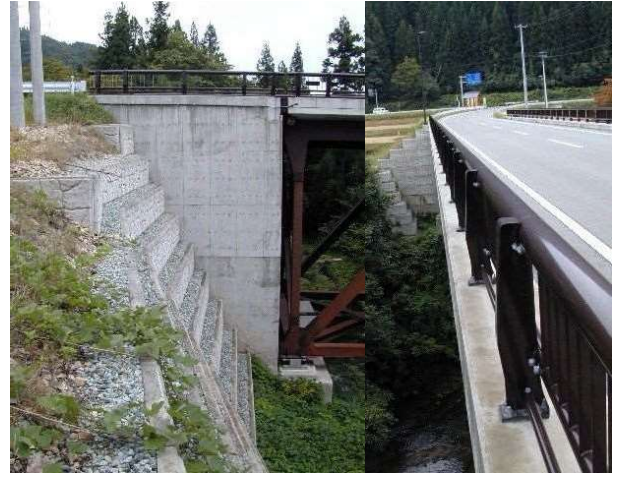
町道櫛山線橋梁整備工事
