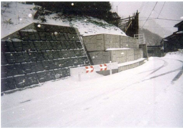
油戸 4 号線道路改良工事
