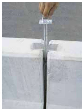
連結筋挿入状況
