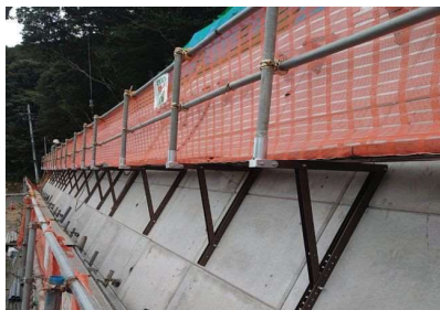
足場を設置した状況
