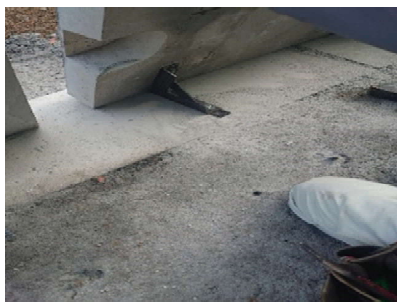
⑤ 埋設金具で専用基礎版と1段目パネルを固定した状況
