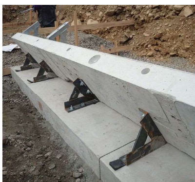
1段目パネル背面の埋設金具
