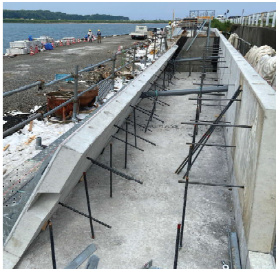
パネル設置後の内側
