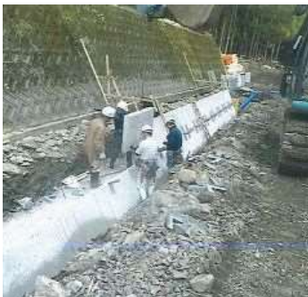
2段目パネルの設置
