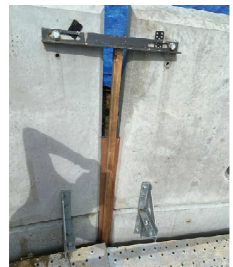
曲線部のパネル間の隙間固定 (パネルのボルト穴を利用)
