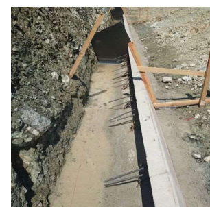
1段目パネルをサポート鉄筋で施工
