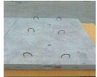
φ6mmのフック筋を設置
