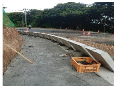
⑥ 1段目パネル設置が完了した状況
