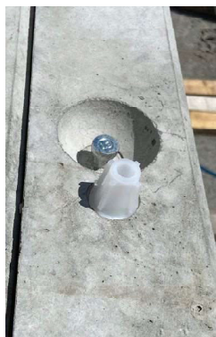
スリットガイドピン (スリットを切り取りズレ調整も可能)
