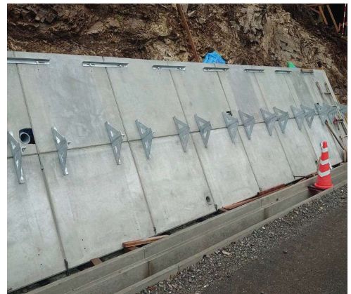
専用固定治具で上下パネルを固定した全体状況
