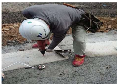
② 埋設金具の設置用アンカー孔の削孔状況
