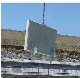
固定治具を両側設置して吊込み
