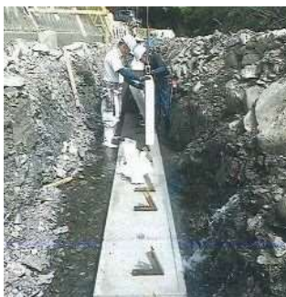
1段目パネルの設置
