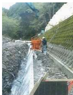
2段目の生コン打設
