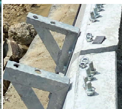
1段目に設置された専用固定治具の詳細
