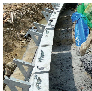
パネルの片側に設置された固定治具
