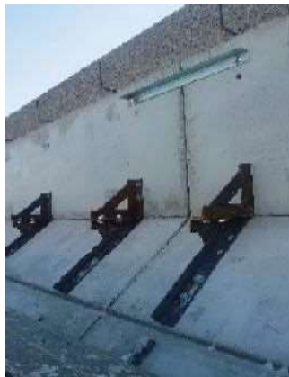
専用固定治具で固定した状況 (上下パネルの勾配が変化)
