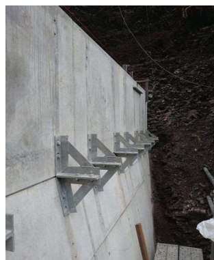
擁壁勾配が変化した場所の施工
