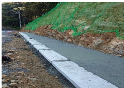
① 専用基礎版を設置した状況
