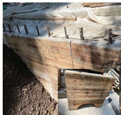
背面を間伐材パネルで施工（内側固定）
