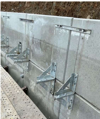
専用固定治具で固定した状況
