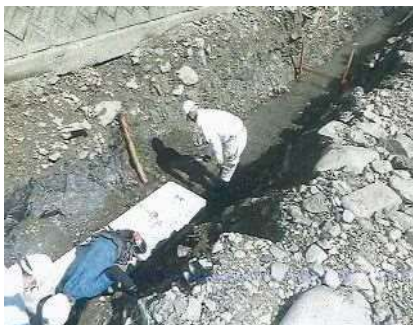
基礎版の設置
