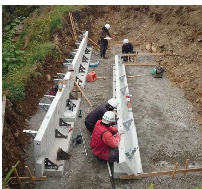
パネル1段目の設置
