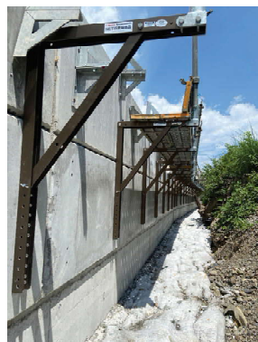
足場支柱をパネルに直接設置
