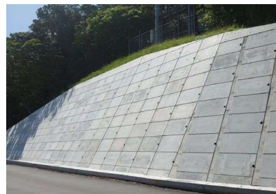
もたれ式擁壁が完成した状況
