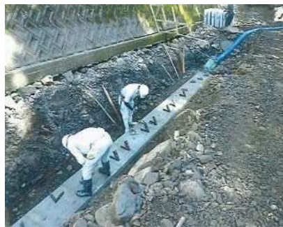
埋設金具の設置
