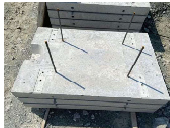
D13-L350の直筋をパネルに設置
