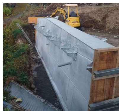
天端まで施工完了
