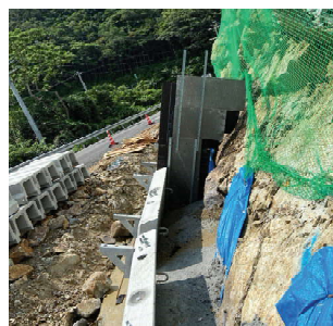
2スパン以上を同時打設するために永久目地型枠を利用 (SF工法)
