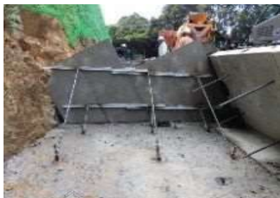
2スパン以上の生コンを同時打設するために、永久目地型枠を利用（SF工法）
