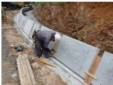
⑦ 1段目の曲線部にできたパネル間の隙間に木製型枠を設置している状況
