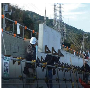
固定治具を片側設置して吊込み
