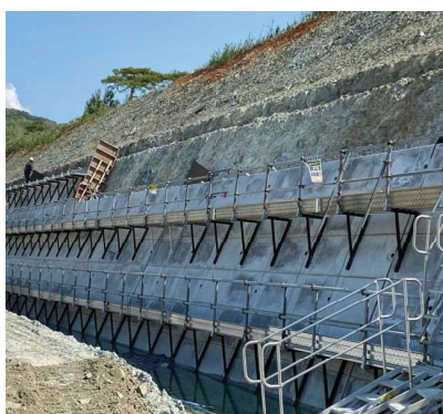
足場設置した状況
