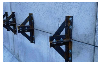
幅2.5mパネルのため3カ所固定
