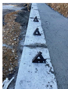
埋設金具（基礎版上に設置）（1:0.5用）
