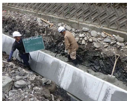
1段目の生コン打設
