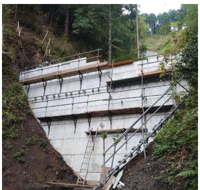
前面側の状況
