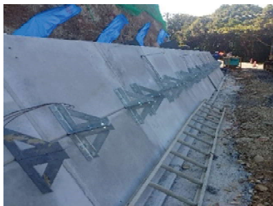
⑧ 1段目と2段目パネル設置完了 (専用固定治具で固定された状況)
