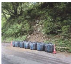
大型土のう対処事例
