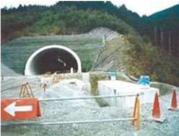
■トンネル洗浄用水槽
