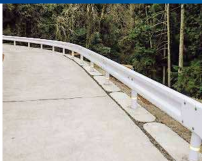
長浜土木事務所(滋賀県)
