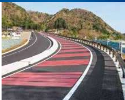
沼津河川国道事務所(静岡県)
