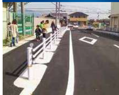
亀山市役所(三重県)
