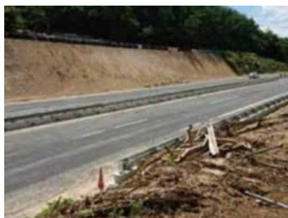
西日本豪雨災害 復旧工事にて
