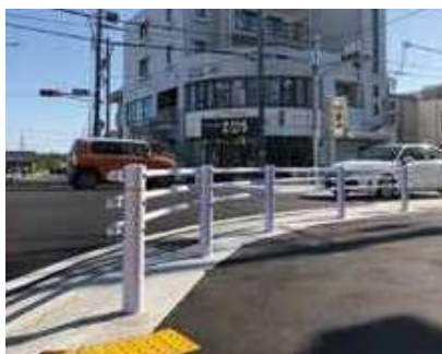
尾張建設事務所（愛知県）
