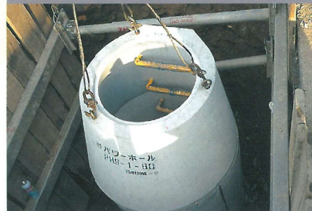
部材の据付け
