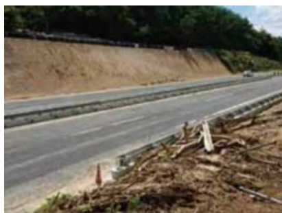
西日本豪雨災害 復旧工事にて
