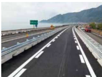
東名高速道路（特定更新等） 富士IC～清水IC間床版取替工事
