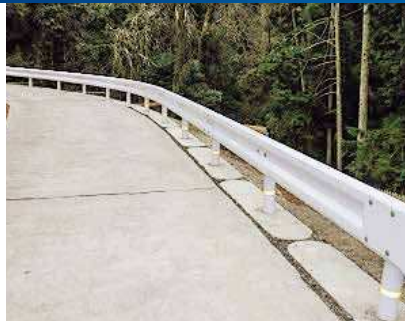
長浜土木事務所(滋賀県)
