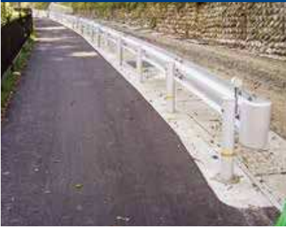
駒ヶ根市役所(長野県)
