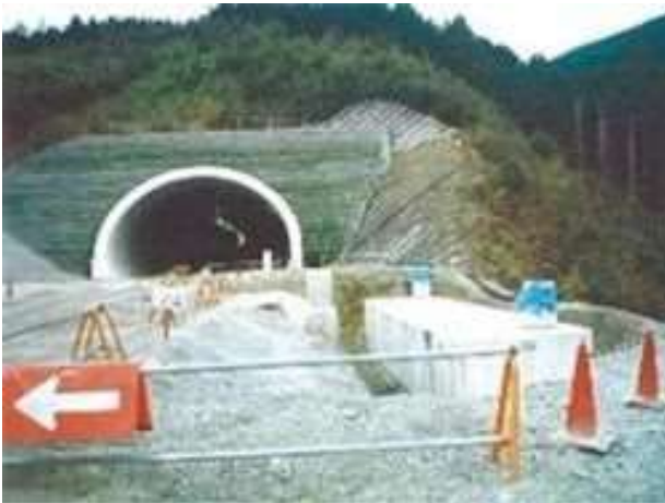
■トンネル洗浄用水槽
